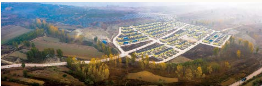
蟒川镇蟒窝村易地搬迁安置点 汝州市乡村振兴局 供图
