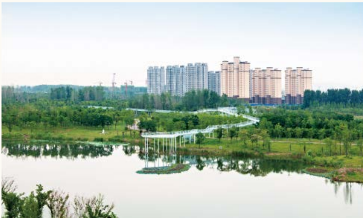
2020年，森林公园新修建的空中栈道 汝州市水利局 供图
