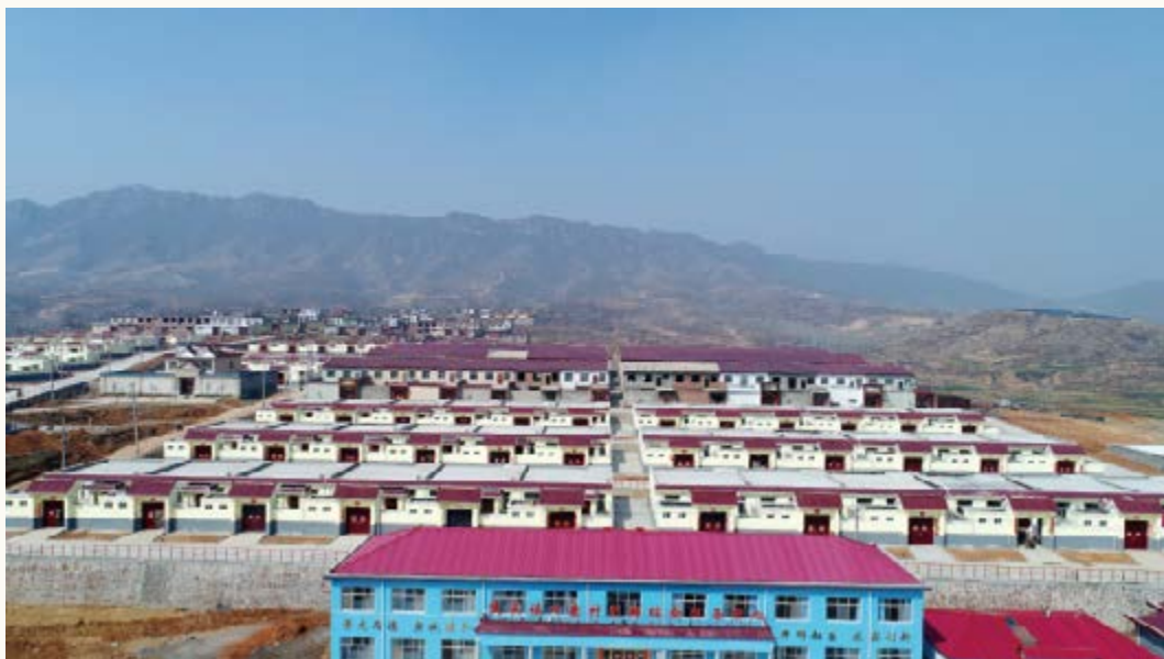
陵头镇叶寨村易地搬迁安置点 汝州市乡村振兴局 供图
