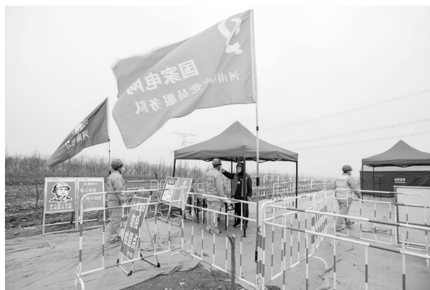
2 月 28 日， \pm 800 千伏陕湖特高压在鲁山县董周乡铁家庄村开工
