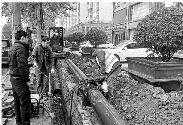
铺设城区供水管道
