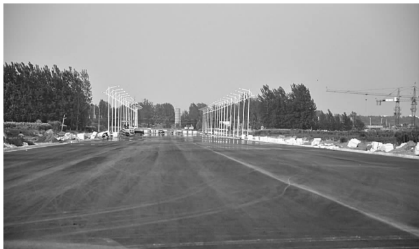
尧山大道东延道路施工现场
