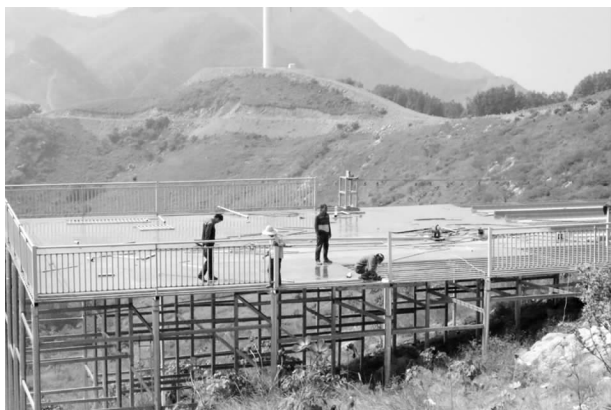
中原云裳牧场项目施工现场 (李东旭/摄)
